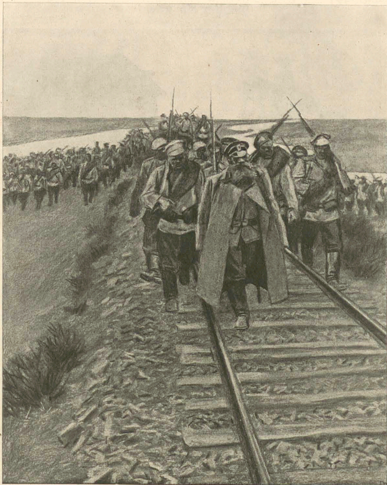
„Versucht hartes Gehen auf dem Geleise — wenn man bedenkt, daß in der anderen Richtung ein feiner Gefangenenzug abgeht!“
